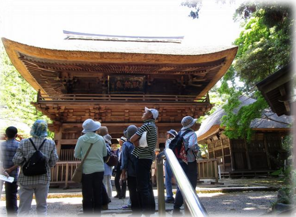
重要文化財 西明寺「楼門」 室町時代(1489)建立、茅葺き入母屋造り
