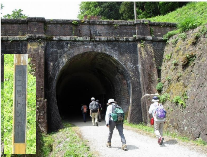
10:50 2号トンネルへ
