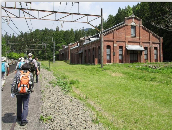
9:55 旧丸山変電所へ 手前が蓄電池室、奥が交流-直流変換器機械室 日本で最初に電化された碓井線の機関車に電気を送るため明治45年に建設された。
