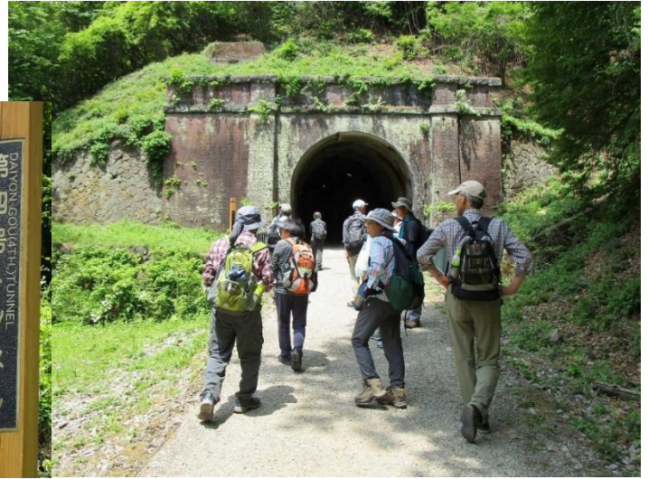
4号トンネルへ
