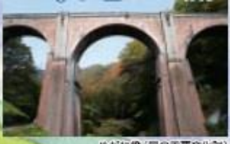
めがね橋(国の重要文化財) 左手に6号碓氷第3橋梁・右手に5号トンネル
