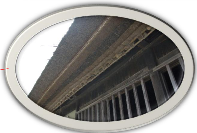
茅葺きの屋根が、茅、稻わら、篠竹など異なる材を重ねる「段葺き」と呼ばれる美しい葺き方になっていました。
