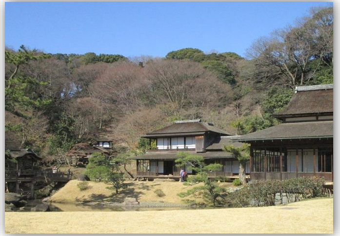
臨春閣(紀州徳川家の別荘、数寄屋造り、重要文化財) 1649年江戸時代建築、1917年(大正6年)移築
