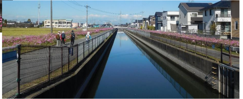
↓柳橋の上から葛西用水路 を進行方向に見る
