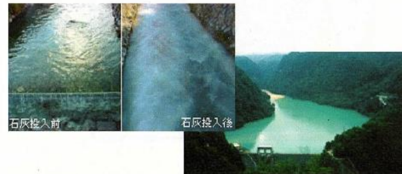
中和工場では石灰を投入して湯川の水を中和。下流の品木ダムで中和促進、中和生成物の沈殿、堆積、浚渫を行う
