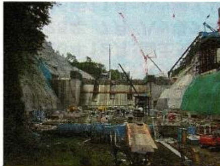
ダム本体コンクリート打設状況(H29.6)
