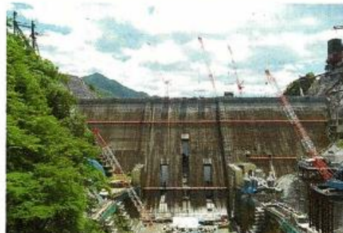
ダム本体打設状況(H30.6)
