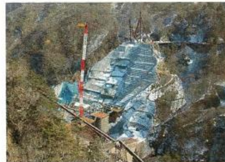
ダム本体右岸掘削状況(H29.3)
